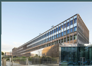
Le pôle Géosciences IGN et Météo France à Saint-Mandé : un bâtiment à Très Haute Performance Énergétique. © Archiliste
