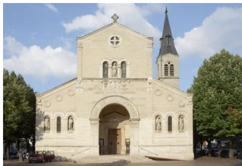
Eglise Saint-Pierre, Charenton-le-Pont
